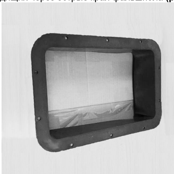
Рисунок 2. Установленная уплотнительная манжета в плитке.
